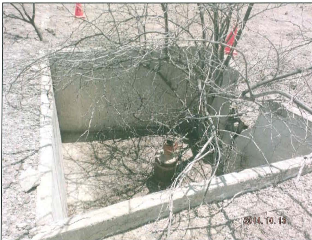
Fotografía N° 1. Pozo A2381 emerge a una altura de 0,7 m desde la base de la cantina de 1,2 m de profundidad.
