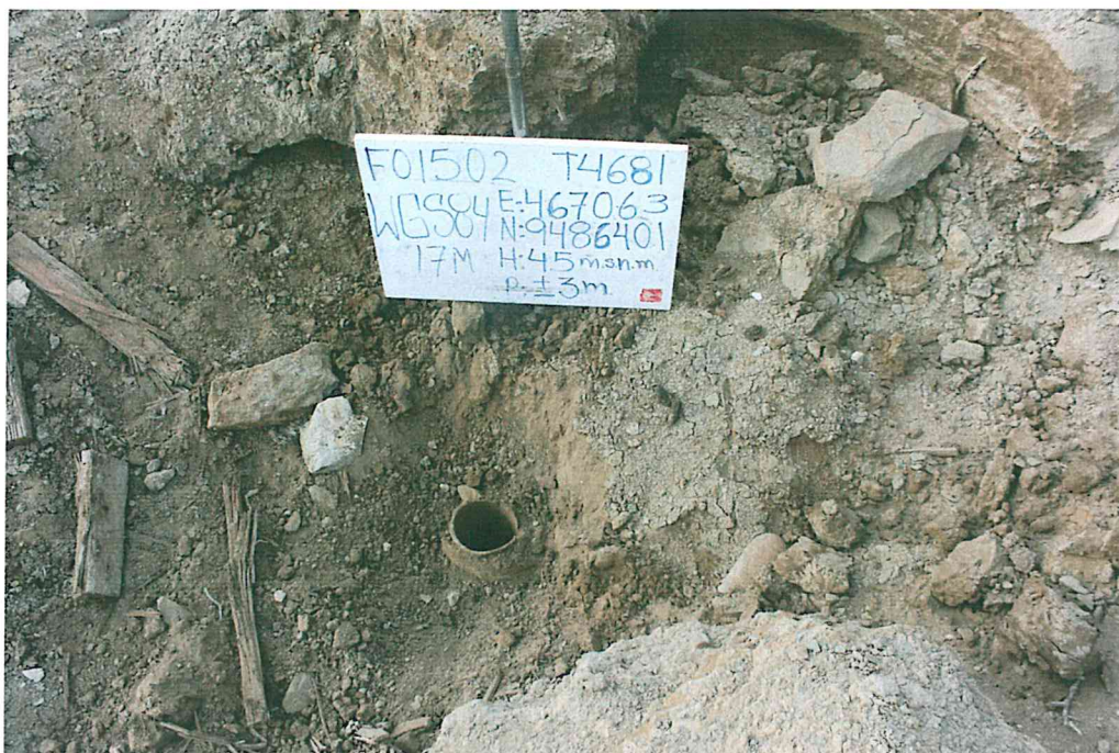
Fotografía N° 1. Pozo T4681, presenta casing de producción abierto y casing de superficie cubierto de tierra.
