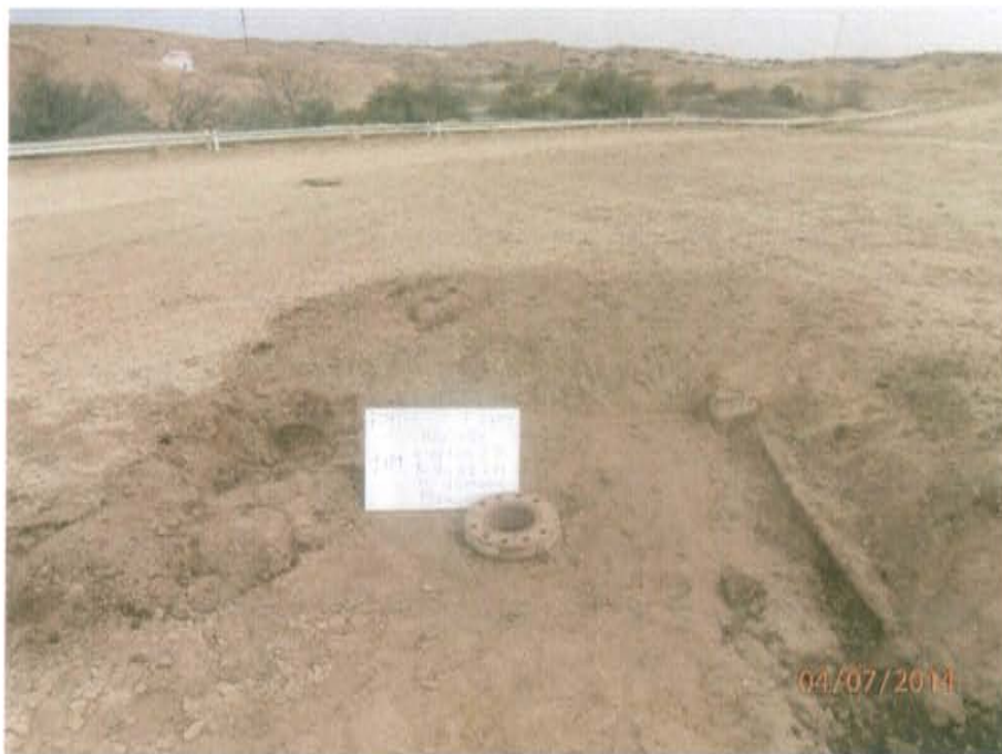
Fotografía N° 2. Vista panorámica del área donde se encuentra el pozo.
