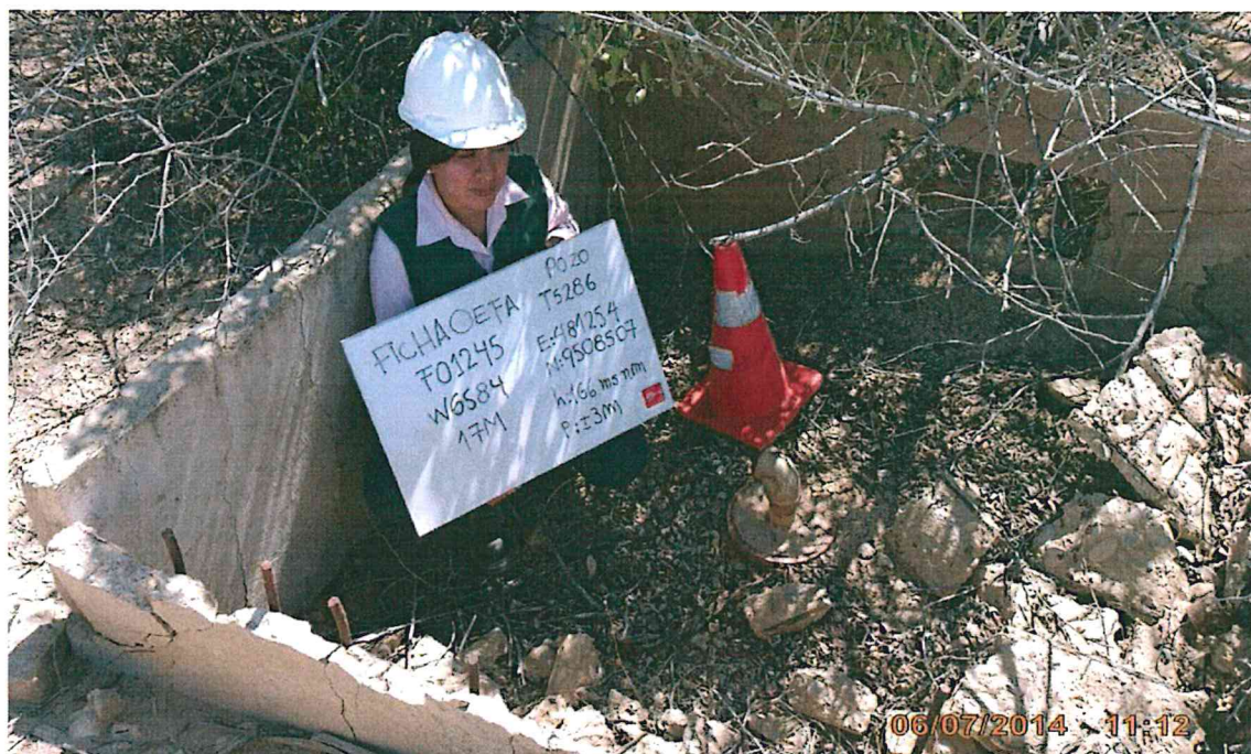
Fotografía N° 1. Vista del pozo petrolero inactivo, se observó casing dentro de una cantina deteriorada.
