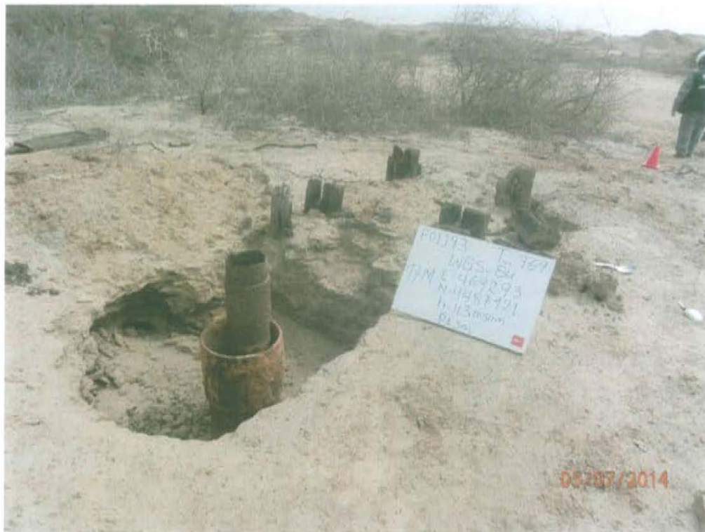
Fotografía N° 1. Pozo inactivo ubicado al interior de un hoyo, con el casing abierto y expuesto al ambiente.
