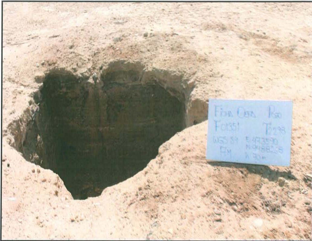
Fotografía N° 1. Pozo T 2298 presenta casing de 11 pulg a nivel de la base de cantina deteriorada y erosionada de dimensiones 2,4 x 2,4 x 3,1 m aproximadamente.
