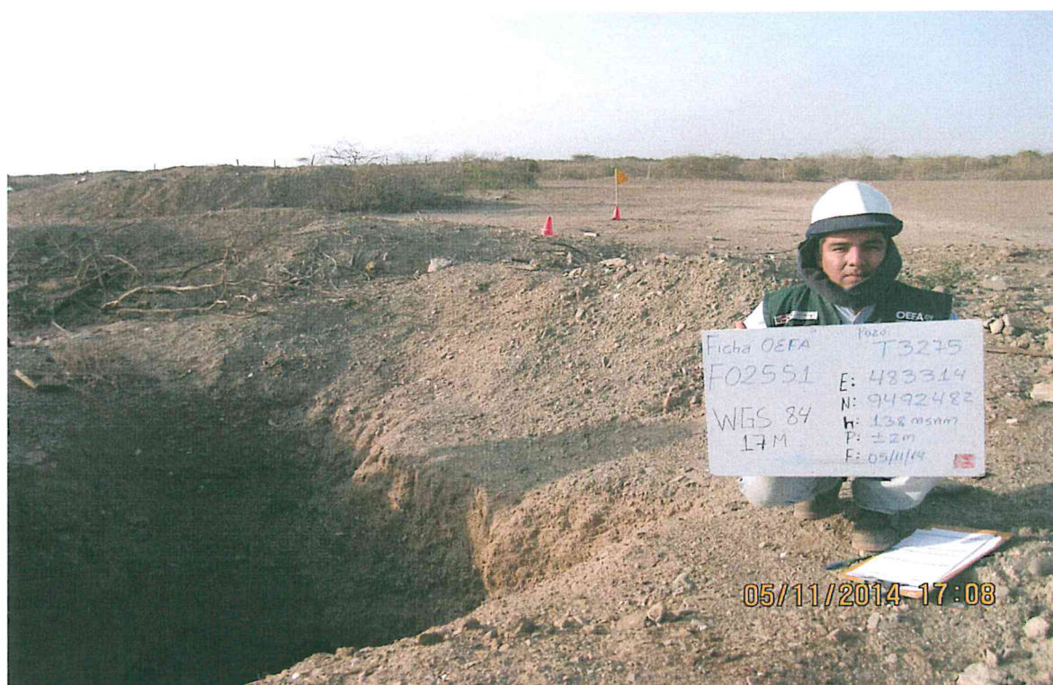
Fotografía N° 1. Pozo no ubicado a nivel superficial ni se visualizó el terraplén; sin embargo, se pudo observar un hoyo de 2,5 m por 3,2 m de lado con una profundidad aproximada de 4,8 m.
