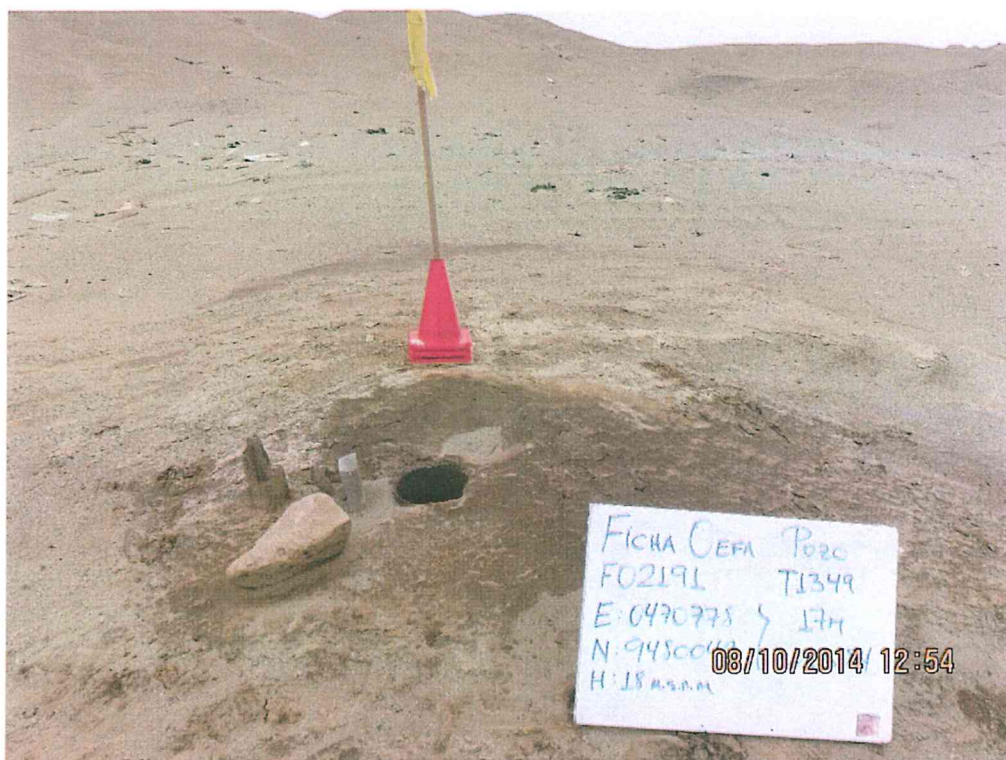
Fotografía N° 1. Vista del pozo T1349 ubicado en una loma de leve pendiente, se observa el casing abierto al ambiente.
