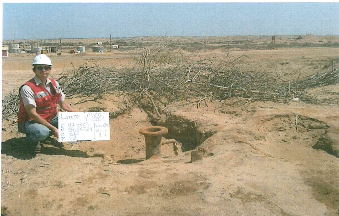
Fotografía N° 01.- Pozo con código PERUPETRO T2861 y con Ficha OEFA F00592, se observa el casing con brida y una tubería lateral, ambas corroídas y no presenta cabezal ni algún elemento de cierre por lo que se encuentra abierto al ambiente.
