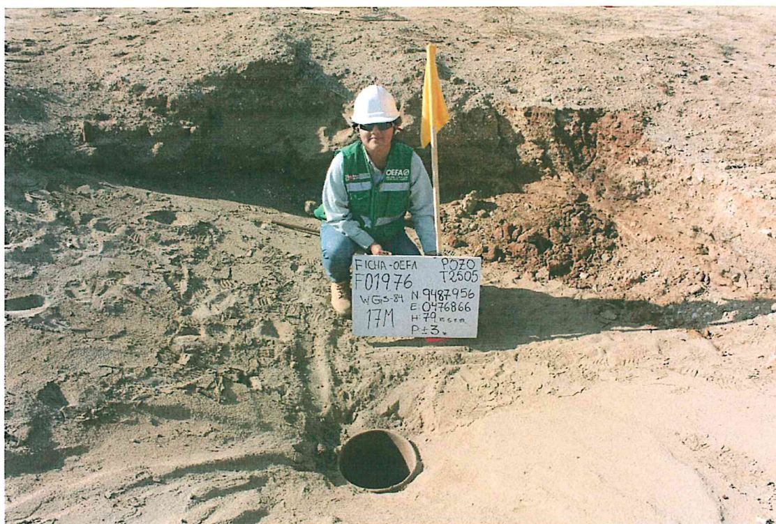
Fotografía N° 1. El Pozo T2505 presenta casing de 12 pulgadas aproximadamente, abierto y sin cabezal ni válvulas que aseguren su hermetismo.
