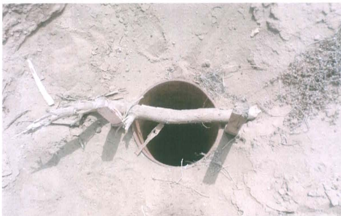
Fotografía N° 1. Pozo con código PERUPETRO T3270 y código Ficha OEFA F02799, se observa el casing corroído, sin cabezal o algún elemento de cierre por lo que se encuentra abierto al ambiente.
