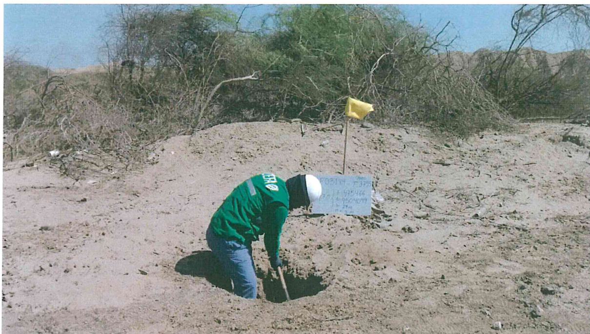
Fotografía N° 1. El equipo de Búsqueda excavando a 0,8 m de profundidad para ubicar el pozo T3755.
