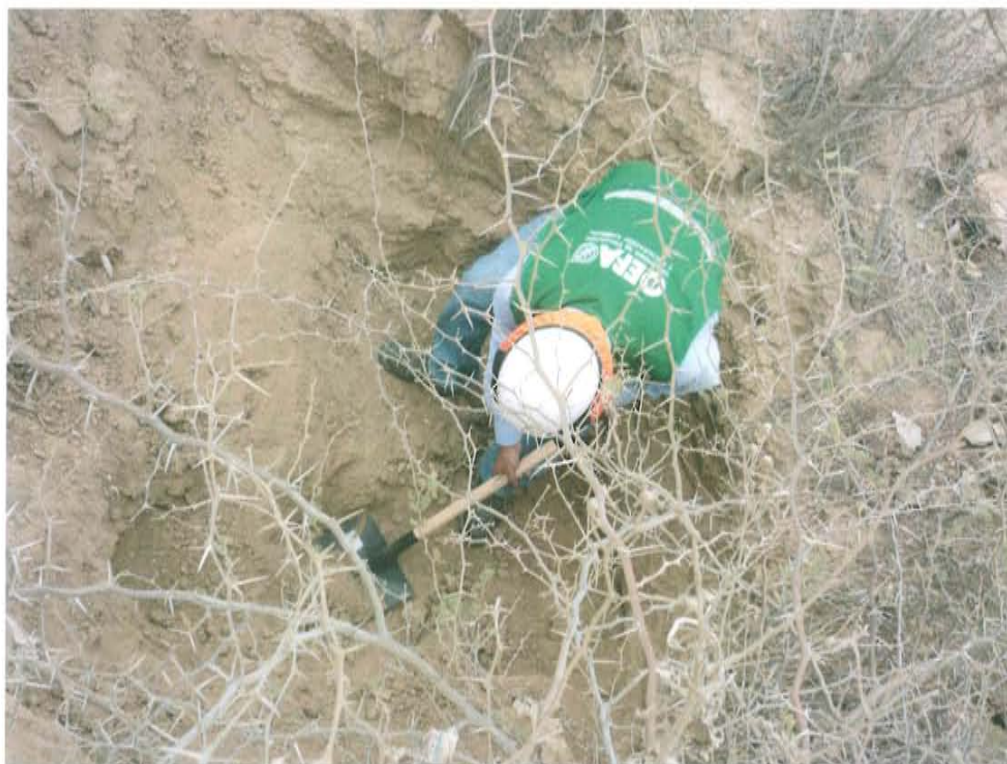
Fotografía N° 3. Se realizó la excavación de 0,5 m en zona georreferenciada afin de ubicar el pozo T2900.
