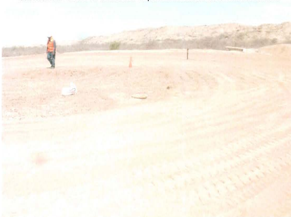
Fotografía N° 2. Vista panorámica del pozo L_491 donde se observa a 14 m. un pozo activo.
