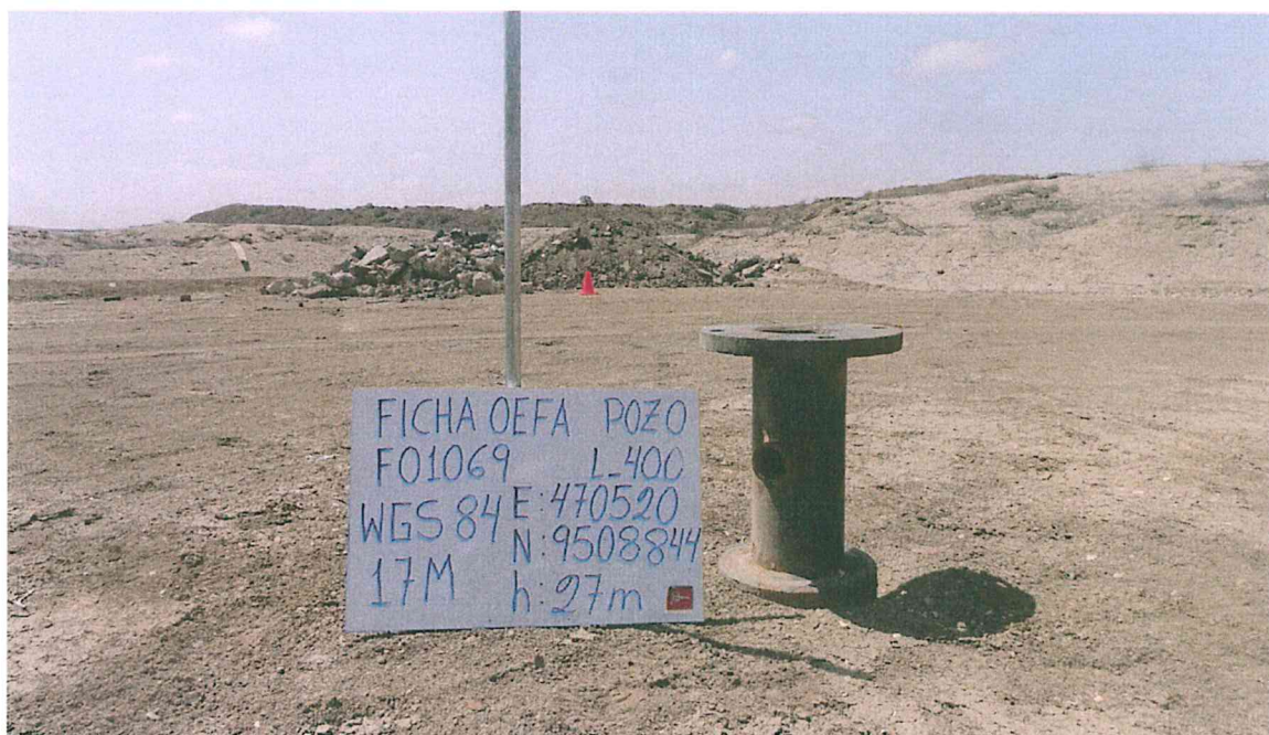
Fotografía N° 1. Pozo ubicado L_400, Ficha: F01069, con casing de aproximadamente 6 1/2 plg de diámetro, con cabezal incompleto de aproximadamente 15 plg de diámetro.
