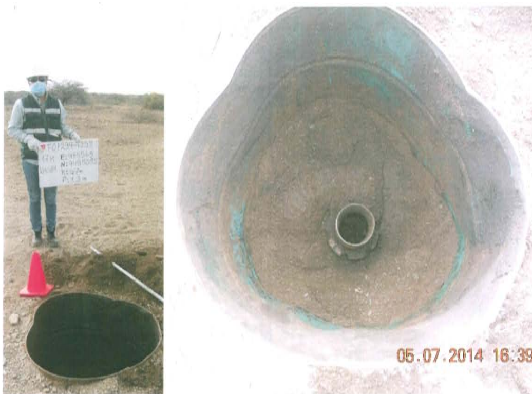
Fotografía N° 1. Identificación del pozo inactivo con código PERUPETRO T2511. Presenta casing que sobresale del interior de una conductora de cilindro de latón, cubierta con suelo con hidrocarburos.
