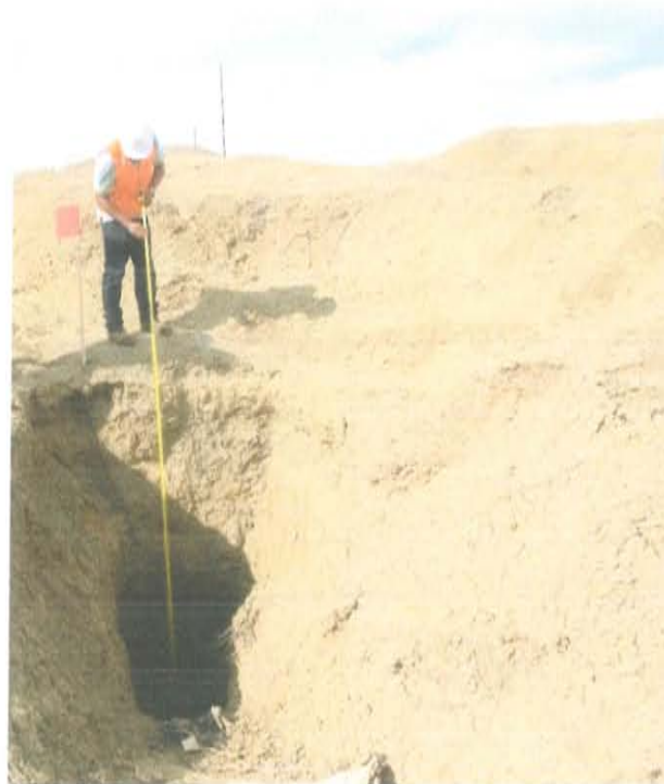
Fotografía N°2. El pozo está ubicado a 3 m por debajo de la superficie del suelo
