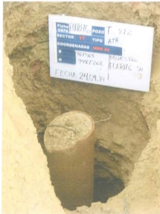
Fotografía N° 1. Pozo T_872 presenta casing cortado y con arena en el interior
