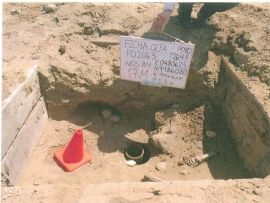
Fotografía N° 2. Se aprecia casing con tubing abierto sin elementos de cierre en superficie que garanticen un cierre hermético del pozo.
