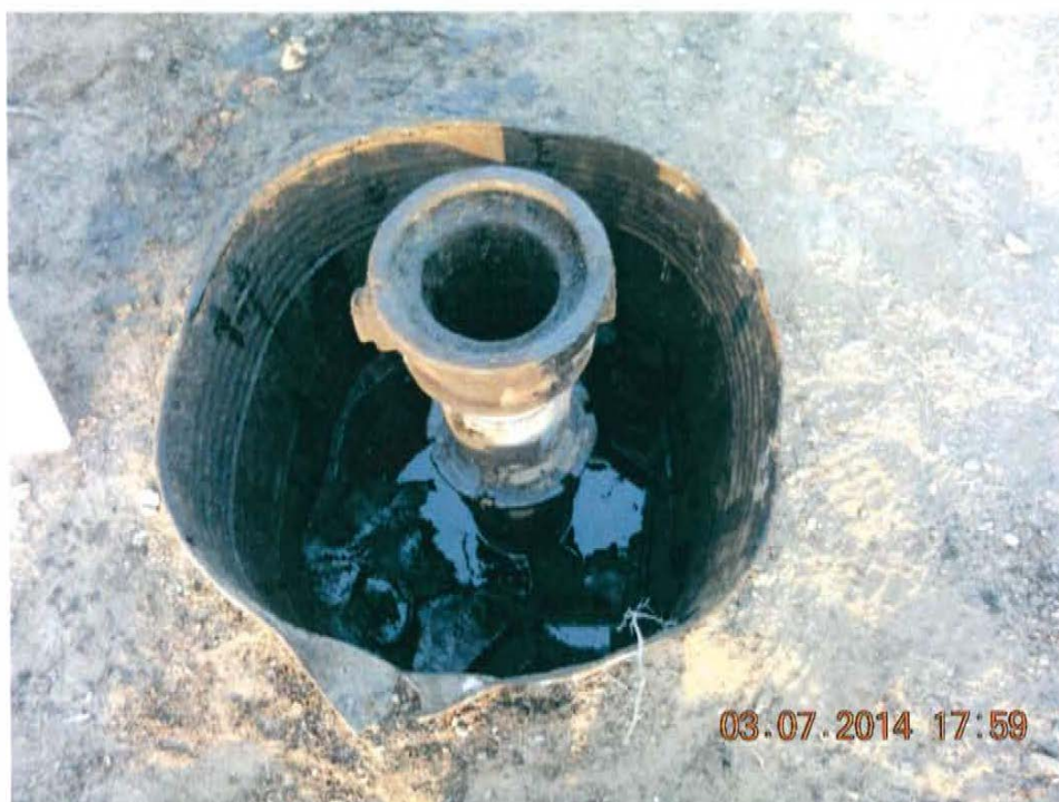
Fotografía N° 3. Se observa el pozo T2011 abierto al ambiente en el interior de un cilindro metálico que cumple la función de conductora, el cual contiene en su interior hidrocarburos líquidos expuestos a la intemperie.
