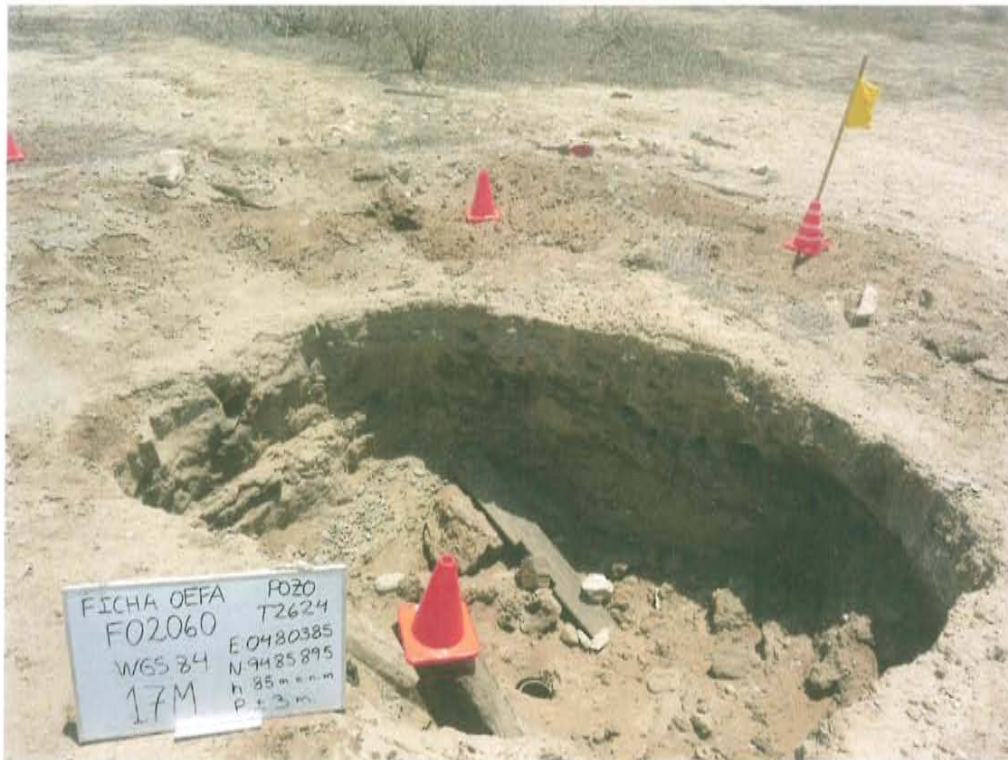
Fotografía N° 1. Pozo con código PERUPETRO T2624 inactivo mal abandonado, se observa casing con tubing en el interior de un hoyo de forma irregular.
