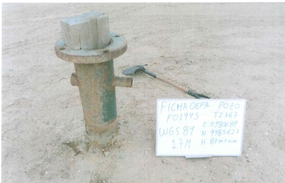
Fotografía N° 1. Pozo con código PERUPETRO T2367 y código Ficha OEFA F01945, se observa el casing con dos tuberías laterales y con cabezal compuesto por una brida que se encuentra abierta al ambiente.
