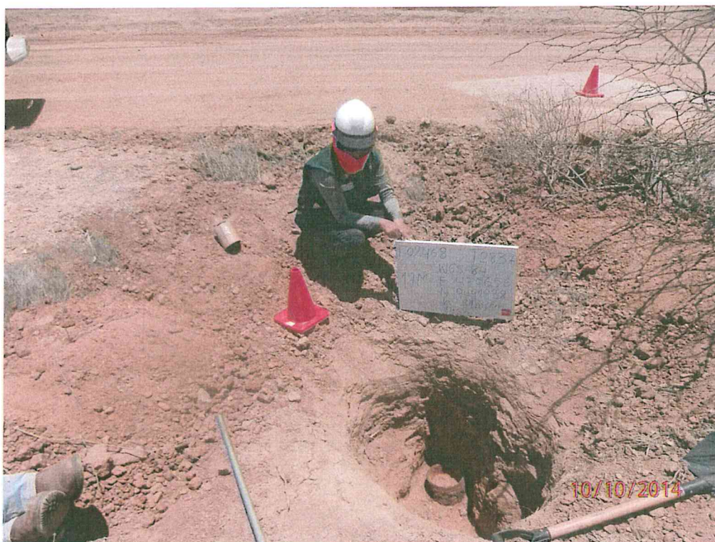
Fotografía N° 1. Se observa el pozo T2837 dentro de una excavación de 0,82 m de profundidad.
