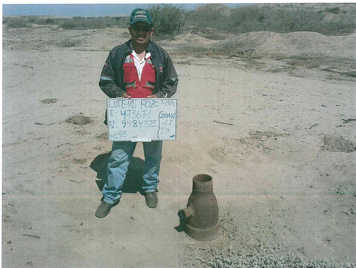
Fotografía N° 2. Ubicación de la boca del pozo se observa un casing con una reducción de media pulgada oxidada y al parecer ha sido cortada.
