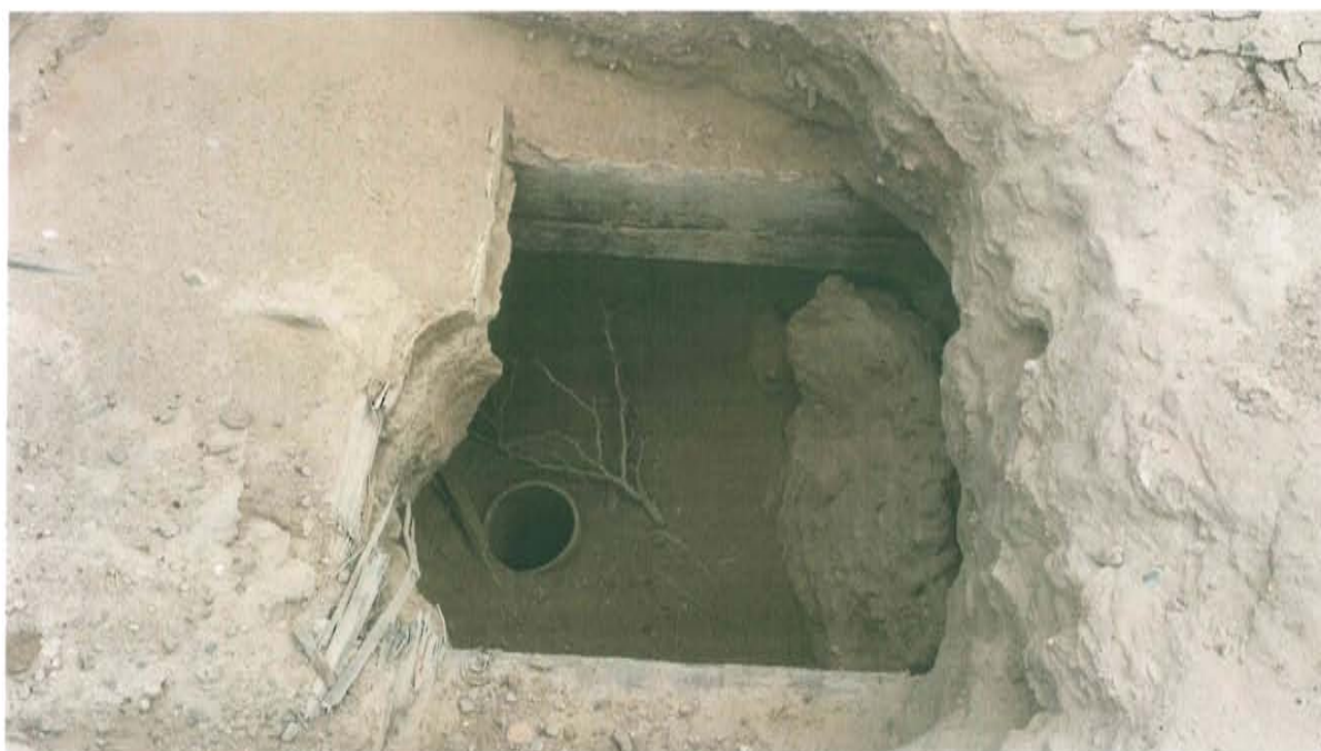
Fotografía N° 2. Vista del interior del hoyo donde se ubica del Pozo T2874 donde se observa la el casing de superficie sobresaliendo una altura aproximada de 0,06m sobre el nivel del fondo del hoyo.
