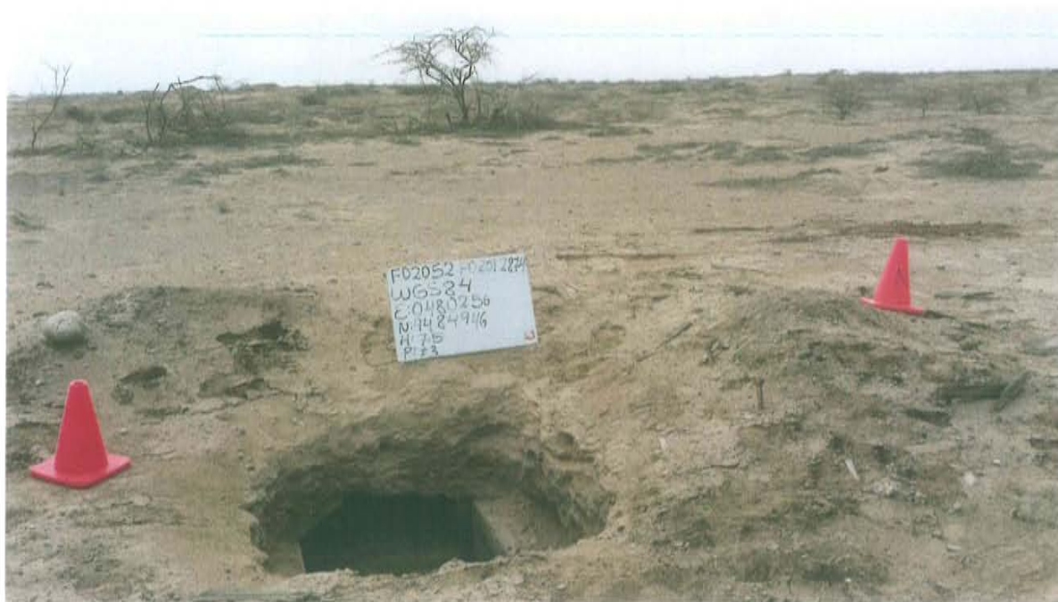
Fotografía N° 1. Pozo inactivo con código PERUPETRO T2874 cuyo casing se encuentra en el interior de un hoyo de forma irregular de aproximadamente 0,8 m de profundidad.
