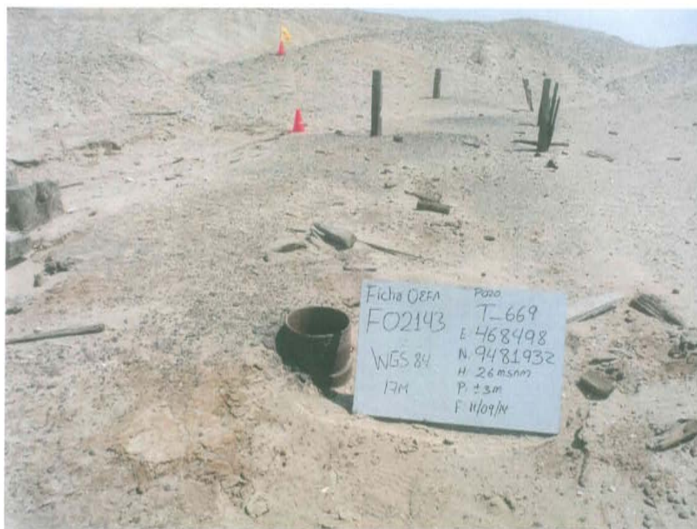
Fotografía N° 1. Identificación del pozo inactivo con código PERUPETRO T_669. Presenta casing corroído, expuesto a la intemperie y con tacones de madera distribuidos alrededor del pozo.
