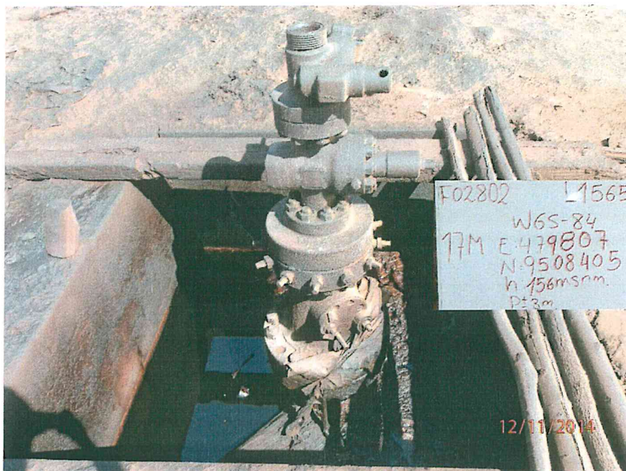
Fotografía N° 1. Se observa el pozo con el casing dentro de una cantina con restos de hidrocarburos.
