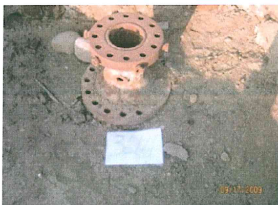
ESTADO DEL POZO EN LA VISITA HECHA POR OSINERGMIN
