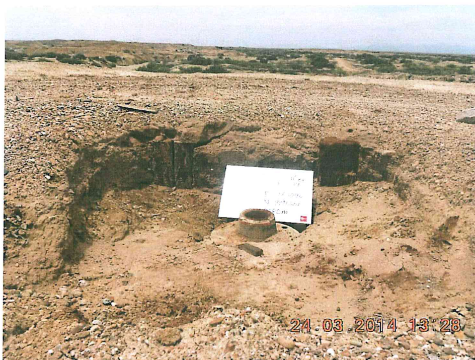
Fotografía N° 1. Vista panorámica del cabezal con brida, ubicado a nivel del suelo, en el interior de una cantina destruida.
