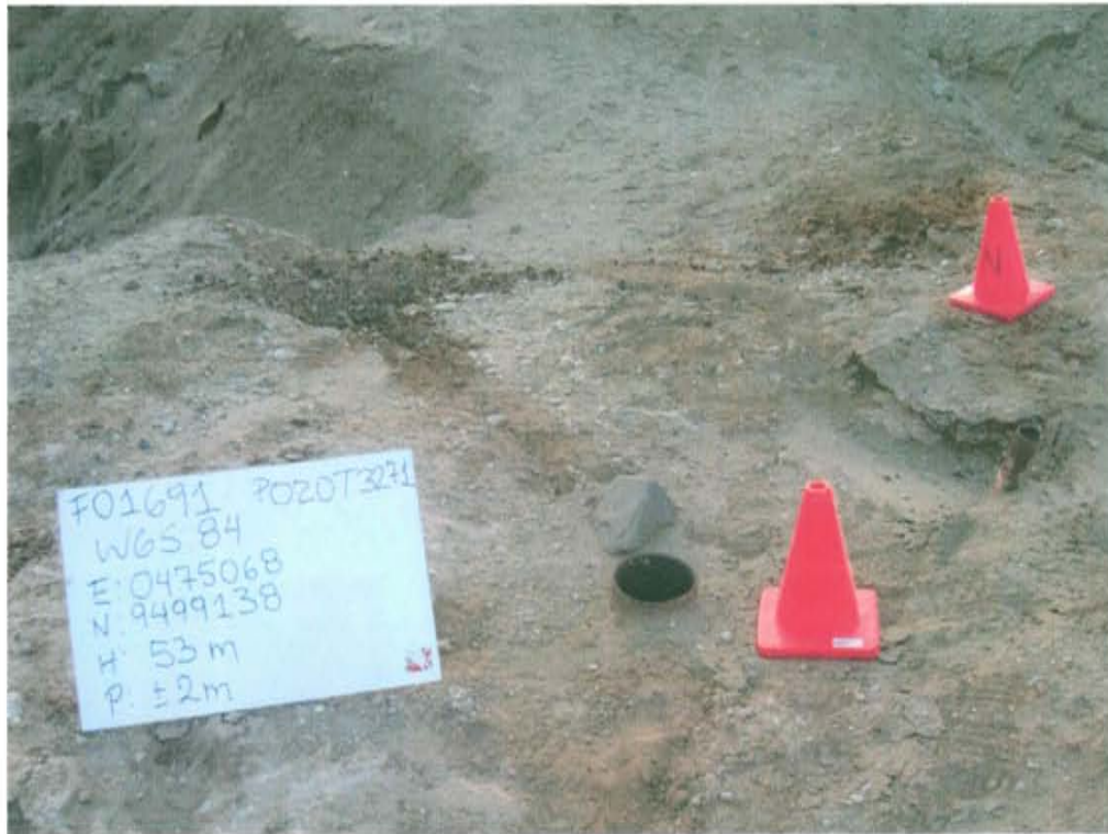
Fotografía N° 1. Identificación del pozo inactivo con código PERUPETRO T3271. Presenta casing sin válvulas que aseguren su hermetismo.
