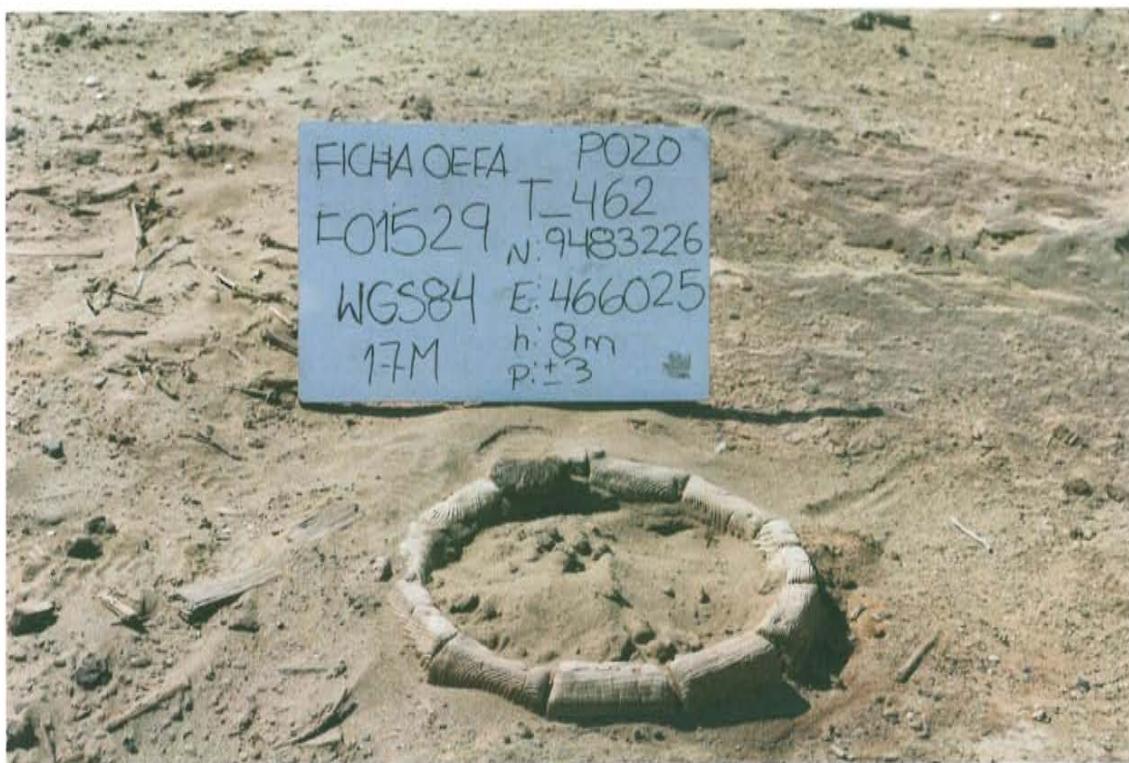
Fotografía N° 1. Identificación del pozo inactivo con código de PERUPETRO T_462. Presenta conductora de madera a nivel de superficie de aproximadamente 19 plg de diámetro.
