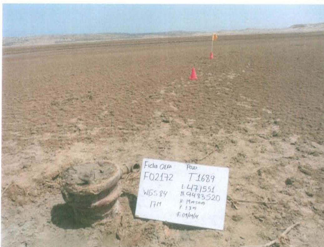
Fotografía N° 1. Se observa casing corroído conteniendo arena en su interior que posiblemente no garantiza el cierre hermético del pozo.
