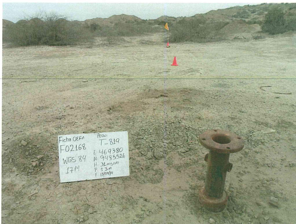
Fotografía N° 1. Se observa el cabezal del pozo que se encuentra abierto al ambiente.
