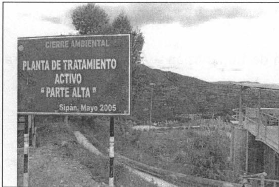
Planta de tratamiento Activo "Parte Alta"
