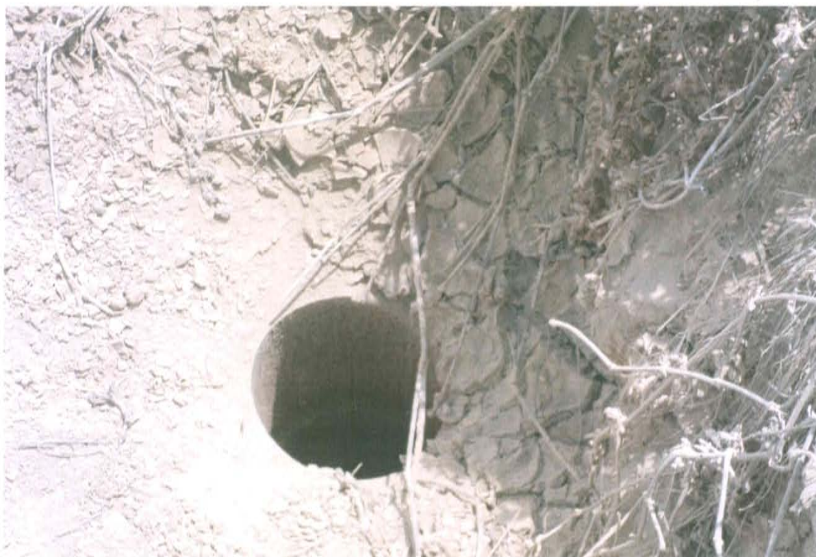
Fotografía N° 1. Pozo con código PERUPETRO T2534 y código Ficha OEFA F02776, se observa el casing corroído, sin cabezal o algún elemento de cierre por lo que se encuentra abierto al ambiente.
