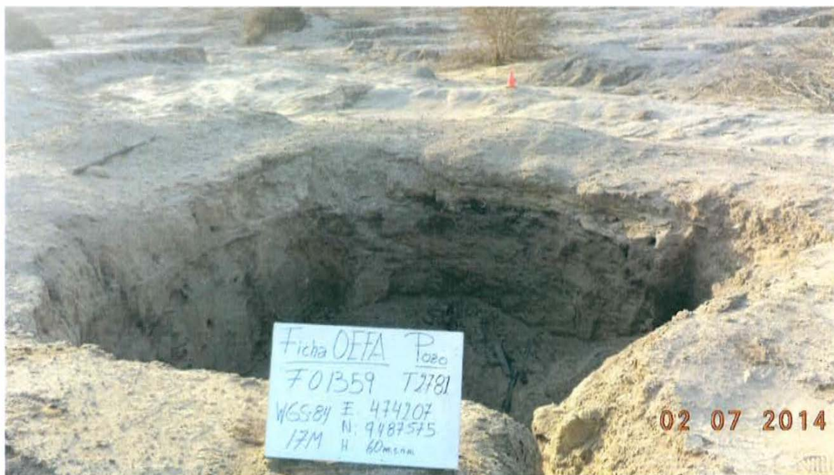
Fotografía N° 1. Vista de la ubicación del pozo inactivo en un hoyo de 3 m de profundidad que no se encuentra cercado ni señalizado.
