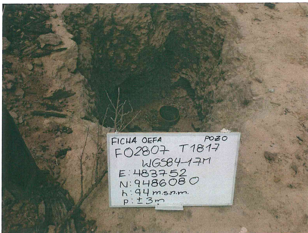
Fotografía N° 1. Identificación del pozo inactivo con código PERUPETRO T1817. Presenta casing descubierta en el interior de una excavación, sin elementos de cierre que aseguren su hermetismo por lo que se considera abierto y expuesto a la intemperie.
