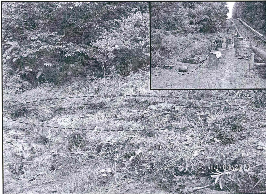
Fotografía N°03: Zona afectada y personal de Pluspetrol realizando labores de limpieza.
