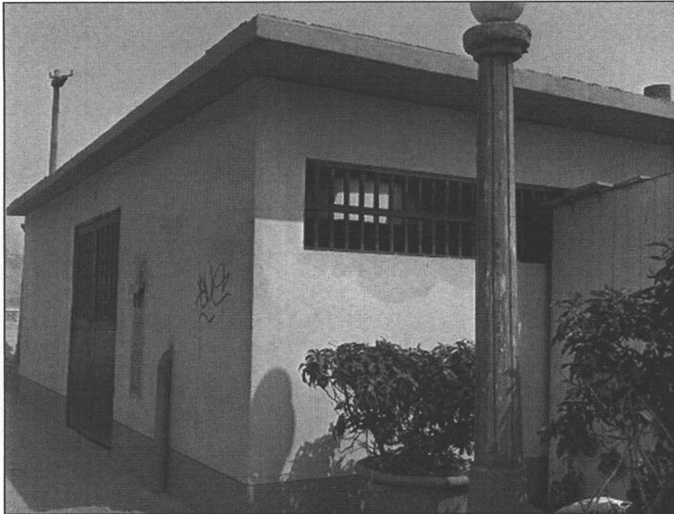
Foto 1: Estación de bombeo de aguas residuales CD-033.
