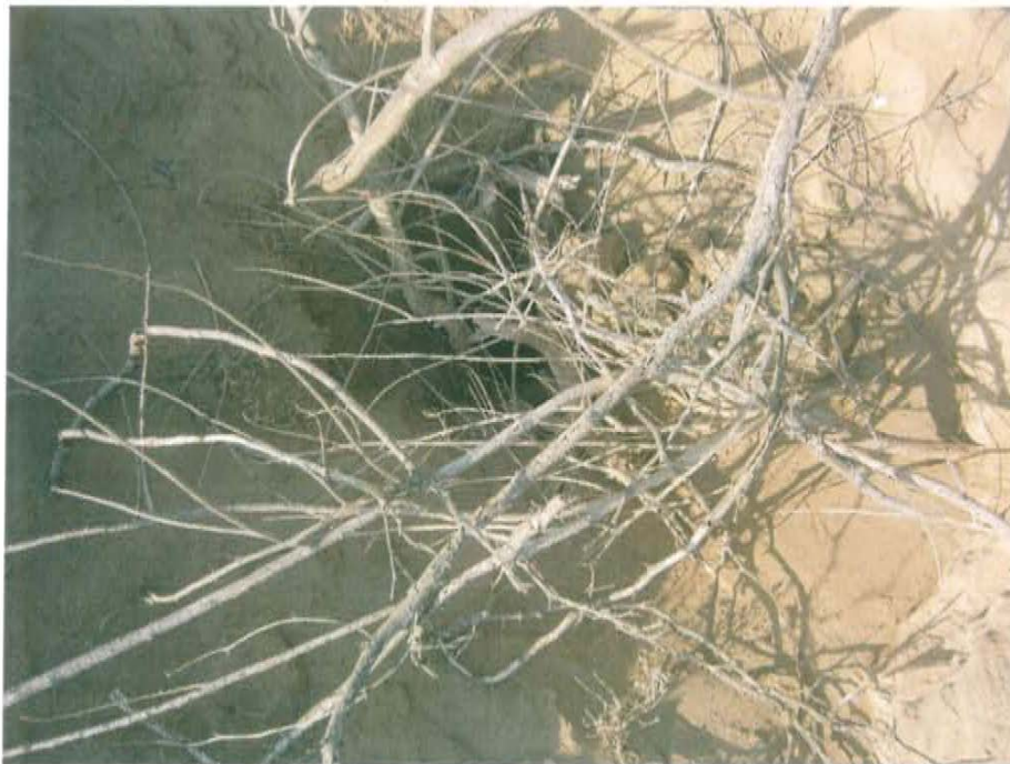
Fotografía N° 2. Se observa que el pozo está cubierto por vegetación autóctona seca, sin embargo no cuenta con elementos de cierre en superficie que garanticen un cierre hermético del pozo.
