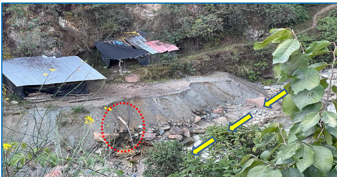
Figura 5-8. Actividad minera informal en el cauce del río Parcoy (flecha amarilla), entre los puntos M-12 (seco) y M-12A-2 (nótese presencia de efluentes - en rojo).
