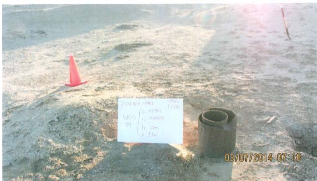
Fotografía N° 1. Se observa 2 casing concéntricos corroídos y abierto al ambiente.
