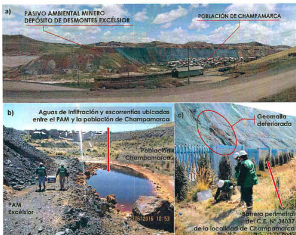
Figura 11-1. PAM Excélsior, observaciones identificadas in situ . a) Imagen panorámica del PAM Excélsior, b) Acumulación de filtraciones y escorrentías al pie del PAM Excélsior con ausencia de una barrera perimétrica y c) Zonas de geomalla deteriorada.
