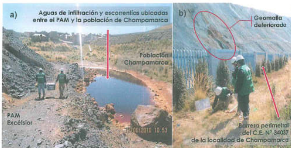
Figura 10-3. Observaciones identificadas en la visita al área de potencial interés ubicado en la localidad de Champamarca, al Este del PAM Excelsior: a) Filtraciones y escorrentías en la zona Sureste del PMA Excelsior y b) Cubierta de geomalla del PMA Excelsior en estado de deterioro. Fuente: Elaboración propia
