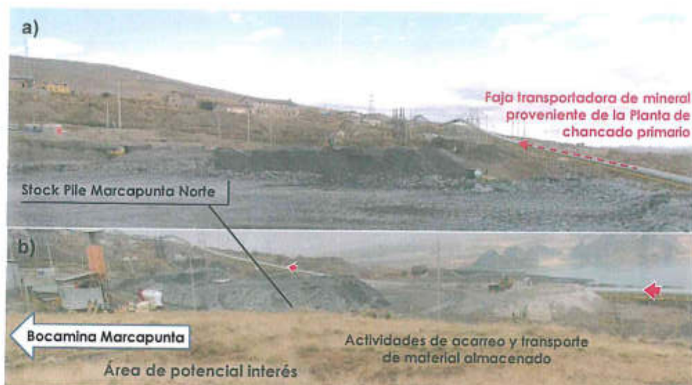
Figura 10-26. Observaciones identificadas en la visita al área de potencial interés ubicada en la localidad de Smelter. a) Vista panorámica del Stock Pile Marcapunta Norte y la faja transportadora de mineral proveniente de la chancadora primaria y b) Actividades de transporte y acarreo del material almacenado en el Stock Pile Marcapunta Norte proveniente de la bocamina Marcapunta.
