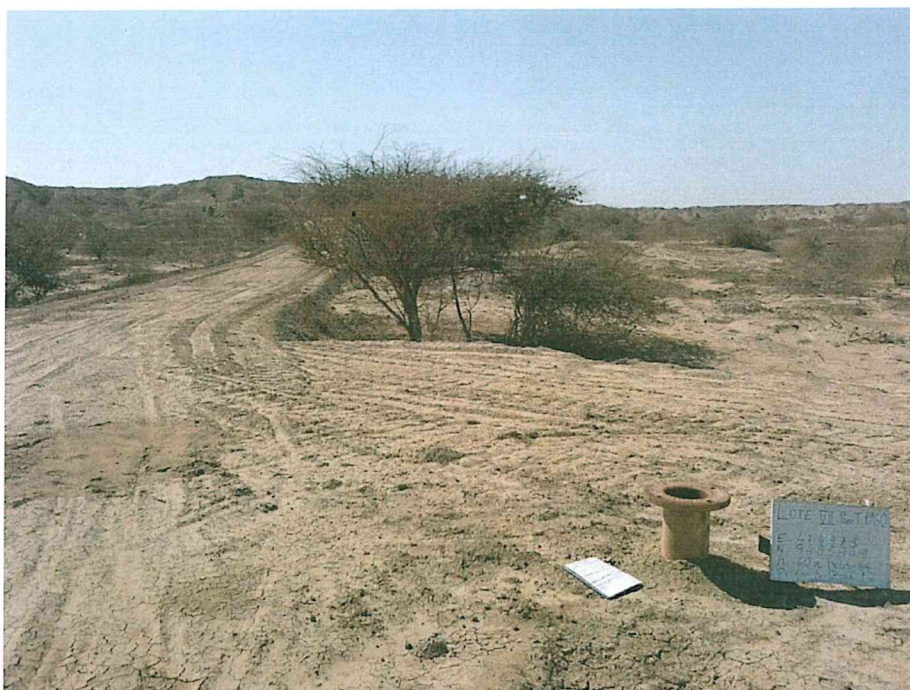
Fotografía N° 1. Se observa el pozo inactivo ubicado en un terreno llano con la estructura del pozo expuesta y en estado de corrosión.
