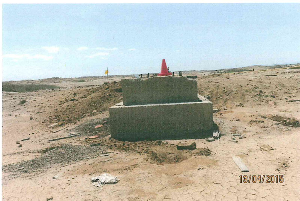
Fotografía N° 3. Se observa una base de concreto muy cercano al área contaminada de hidrocarburos.
