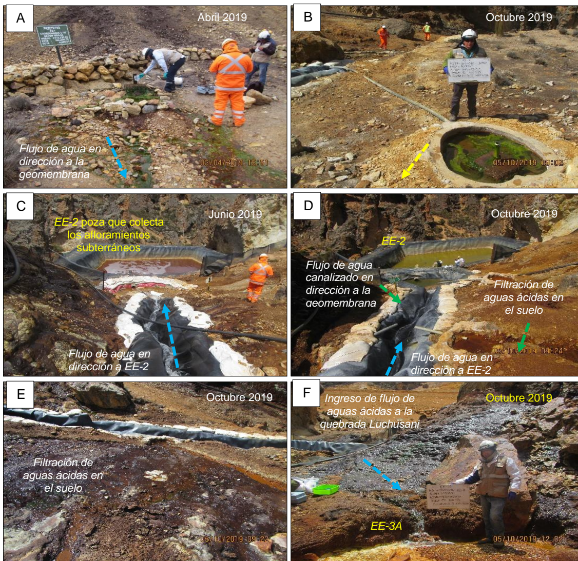
Figura 7.11. Filtración en el suelo de la surgencia del piezómetro (PZ-1) en A) abril 2019 y captado en B) octubre 2019, flujo de agua en dirección a EE-2 en C) junio 2019 y D) octubre 2019, filtración de aguas ácidas en el suelo en E) octubre 2019; y descarga de parte de los afloramientos ácidos (EE-3A), que no fueron captados, a la quebrada Luchusani en F) octubre 2019
