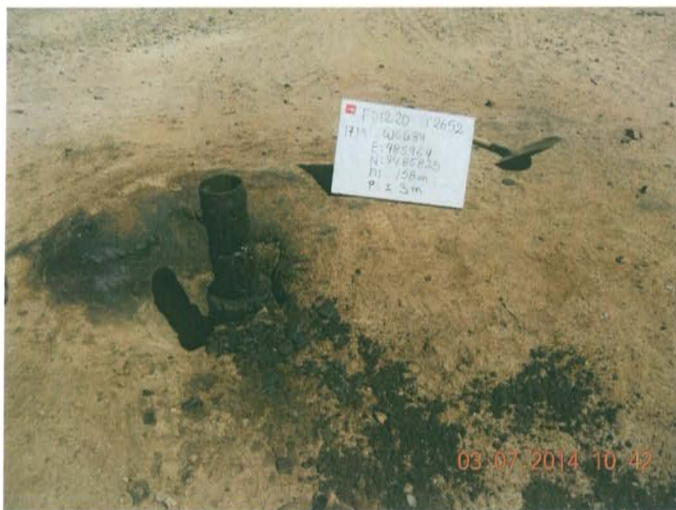
Fotografía N° 2. Vista y ubicación del pozo T2652 dentro de un pequeño hoyo de 0,95m² x 0,2 m de profundidad.
