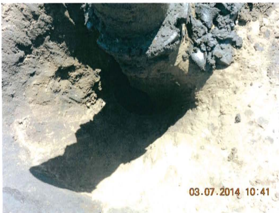
Fotografía N° 3. Se observa pozo abierto y expuesto al ambiente, que se encuentra cortado en un lado del extremo inferior del casing de superficie, de donde posiblemente se extraen artesanalmente hidrocarburos.
