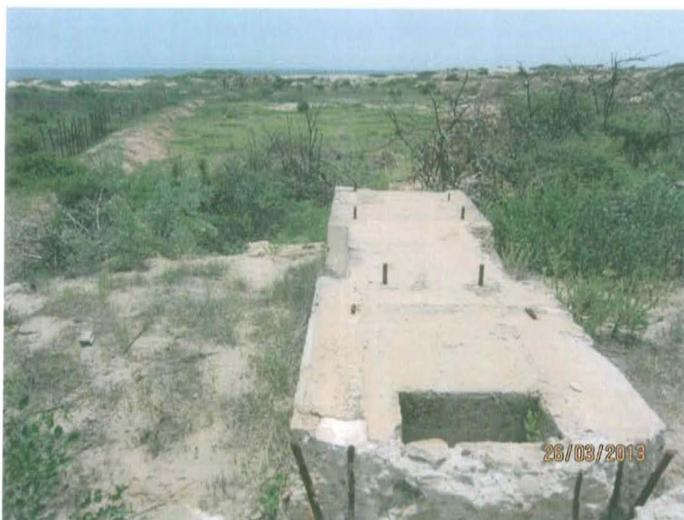
Fotografía N° 1. Se observa una estructura de concreto donde posiblemente se ubicarla el Pozo P__1.
