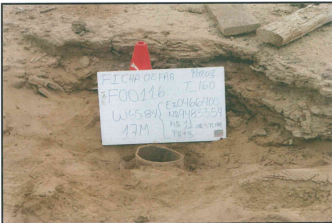
Fotografía N° 1. Pozo con código PERUPETRO T_160, se visualizó casing de 7 pulgadas que sobresale 0,10 m sobre el nivel del suelo, se observa residuos sólidos como maderas y plásticos.
