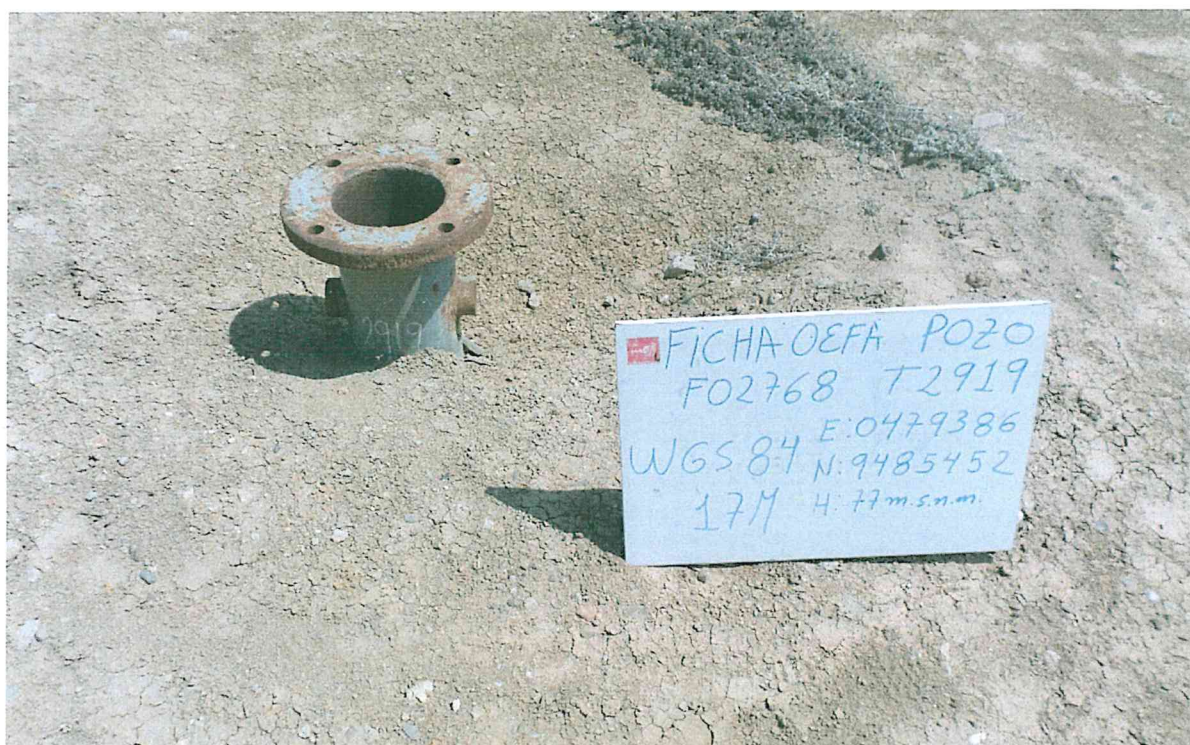
Fotografía N° 1. Pozo con código PERUPETRO T2919 y código Ficha OEFA F02768, se observa el casing con dos tuberías laterales unido a un cabezal compuesto sólo por una brida abierta al ambiente.
