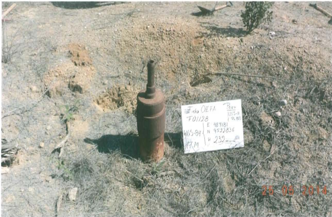
Fotografía N° 1. Identificación del pozo inactivo con código EP-82 (P-82). Presenta casing unida a una tubería de reducción abierta y expuesta a la intemperie.
