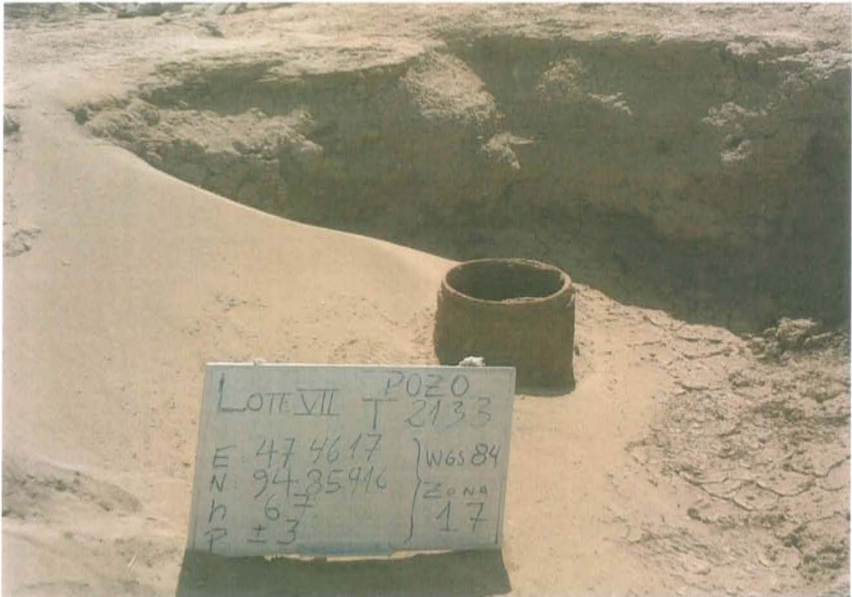
Fotografía N° 01.- Pozo con código PERUPETRO T2133 y con código Ficha OEFA F00591, se observa el casing corroído que no presenta cabezal por lo que se encuentra expuesto al ambiente.
